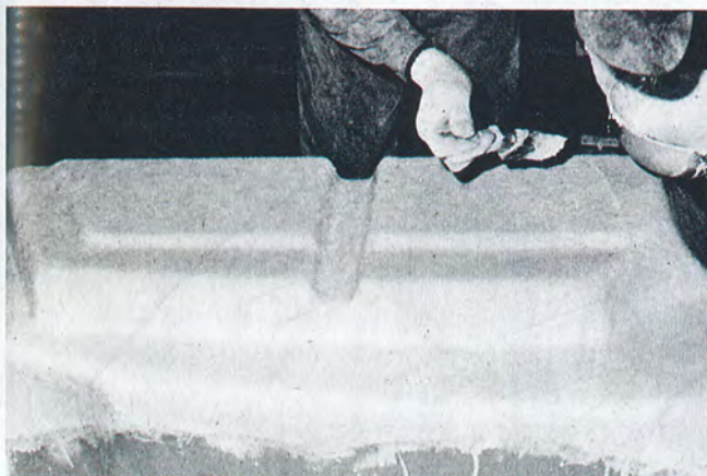
メス型にグラスファイバーをプラスチック溶液で貼り合わせていく。
