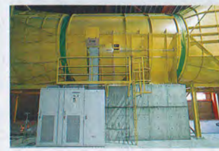
定格出力600kwの巨大モーター。これは一般家庭では考えられないような数値だ。また、エアータンネルに不要な振動を伝えるないように、独自の基礎を持つ。
