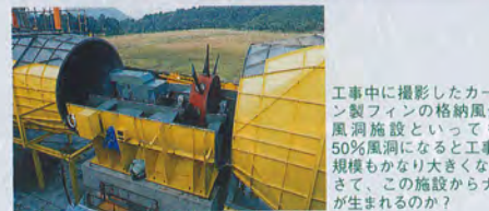
大型フィンにはカーボン繊維製。高速で回転してもねじれがなく、回転数に対して一定の風量が保証される。それにしても大きい!!
