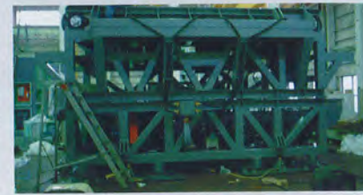
建設中のムービングベルト部。高速でベルトを回転させるため、かなりの精度が求められる部分だ。童夢では、その開発ノウハウを持っているのだ。
