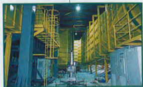
測定部全体を囲むように両側 (上流側と下流側) に太い鋼材による門状の骨格が立ち、その上部中央をやはり太い鋼材の梁が縦通している。この梁の中央からストラットを伸ばしてモデルを固定する。その支持構造がたわんだり振動したのでは、精度の高い測定ができない。そこで思い切り強固な構造にしたのだ。
