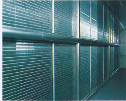
大型の水冷ラジエーターは風路内部の温度が上昇するのを防ぎ、風洞実験に最適な環境を作りだすことに貢献
